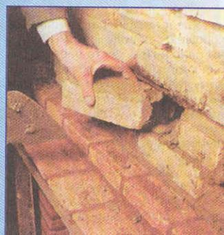
Железобетонная перемычка кладется до дымовой трубы. На уложенную полосу выкладывают профилированные керамические плитки, поверх которых кладут ряд кирпича.
