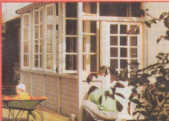
После предварительной обработки антисептиком веранда покрывается двумя слоями микропористой краски для наружной покраски деревянных поверхностей. Впоследствии покраску (вместе с предварительной обработкой) нужно будет регулярно обновлять.
