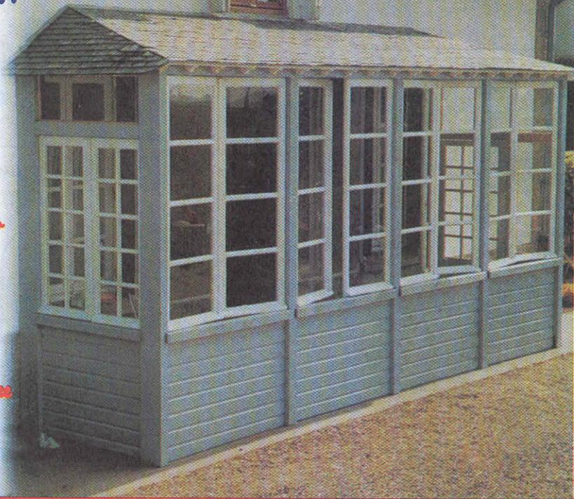
Веранда состоит из застекленной передней стены и двух небольших боковых, в одну из которых врезана входная дверь. Трехскатная кровля ее покрыта шифером, но можно использовать и другие кровельные материалы.
