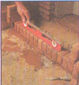
Низ топки камина заканчивается рядом кирпича, выложенного вертикально. Расстояние между внешним его краем и стенкой камина должно быть равно 40 см.
