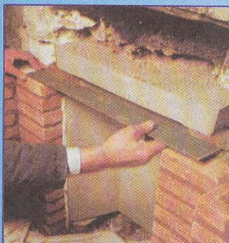
После того как вы выложили топку каминна, сверху, на раствор кладут железную полосу и устанавливают перемычку.
