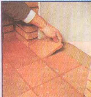
Под топку выкладывается поверх кирпича огнеупорными глиняными плитками на шамотном растворе.
