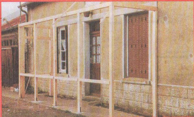
*Деревянный каркас веранды устанавливается на уже существующую бетонную дорожку. Он крепится к ней с помощью привинчиваемых металлических уголков. Примыкая к фасадной стене дома, веранда укрывает входную дверь дома и два его окна.*
