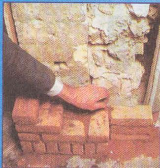
Камин соединяют с прилегающей к нему стеной при помощи анкеров. Прокладывают компенсационную ленту.
